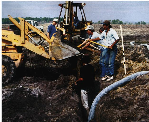
Figura 2.46.- Excavación para drenaje.
