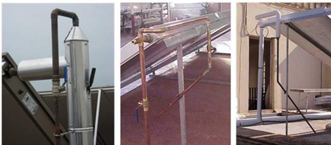
Figura 82: Ejemplos de purgadores manuales de aire en salida de aire con escapes conducidos
