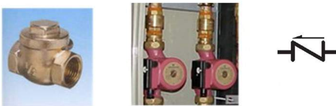
Figura 77: Ejemplo de válvula de retención, instaladas en impulsión de bombas y símbolo habitualmente utilizado
