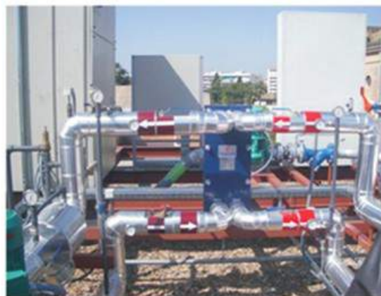
Figura 72: Esquema (izq.) y ejemplo (der.) del conexionado de un intercambiador solar independiente
