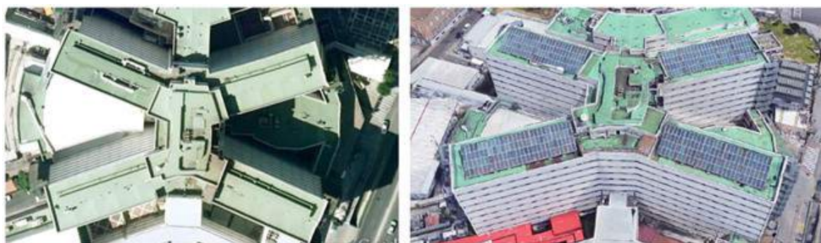
Figura 3: Cubiertas de un hospital antes y después de implantar la instalación solar térmica
