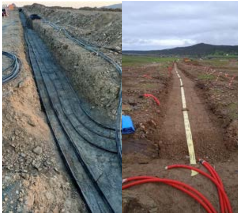
Figura 28: Ejemplo canalización.
