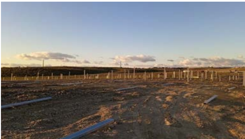
Figura 29: Ejemplo hincas en terreno.
