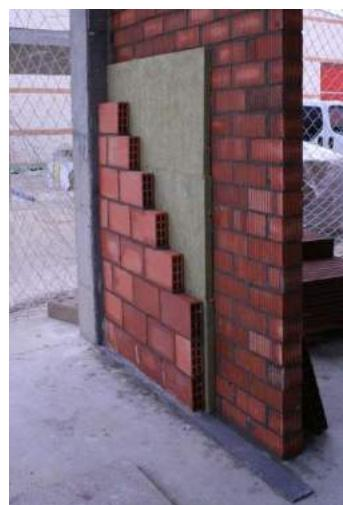
Figura 64 Ejemplo de separación vertical de doble hoja
