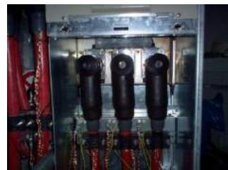
Figura 43 Conexión frontal celda de protección
