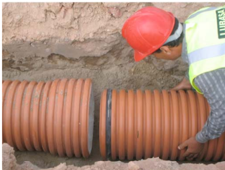
Fig. 6. Facilidad de instalación en obra de tubos de materiales plásticos.
