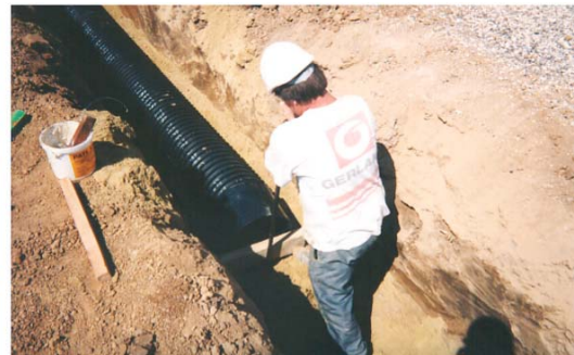
Fig. 6. Facilidad de instalación en obra de tubos de materiales plásticos.
