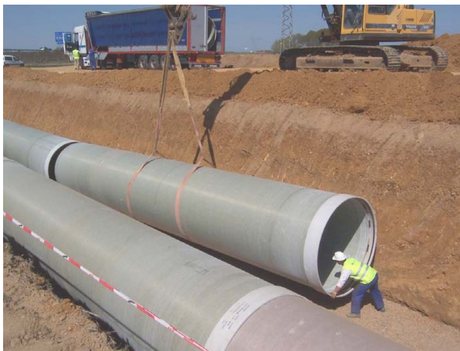
Fig. 17. Tubería de PRFV DN 2.000
