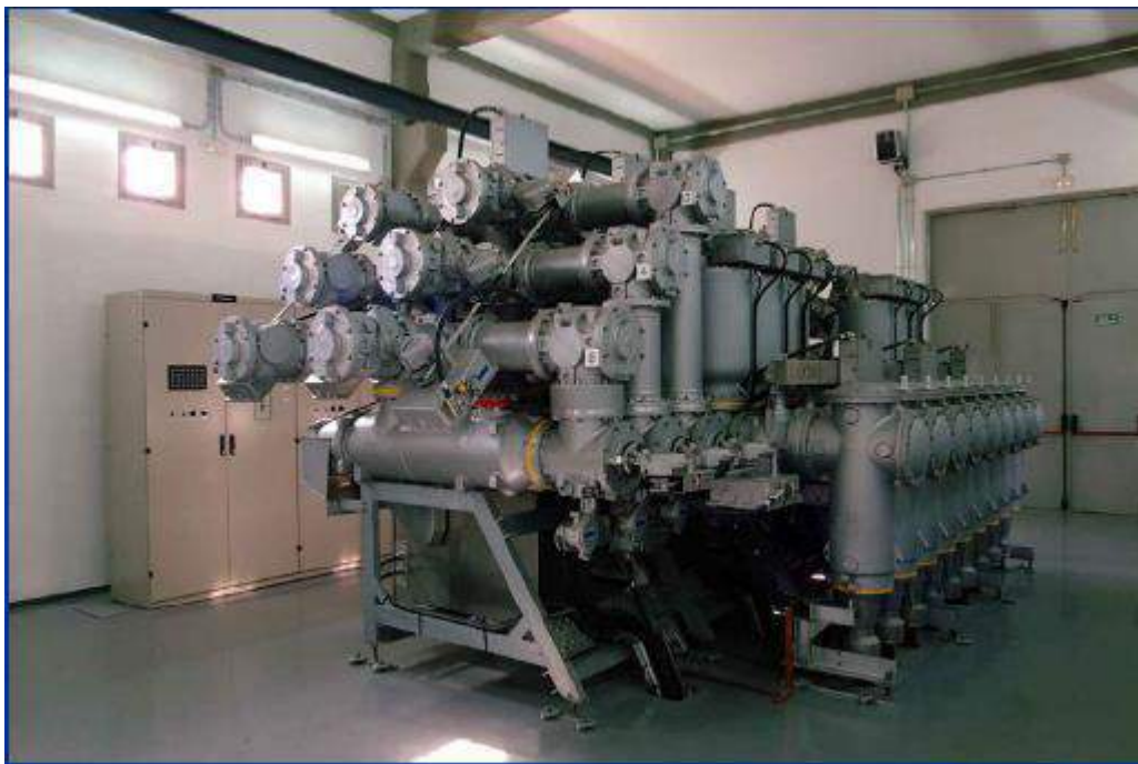
Ilustración 2-3: Subestación de interior tipo GIS.
